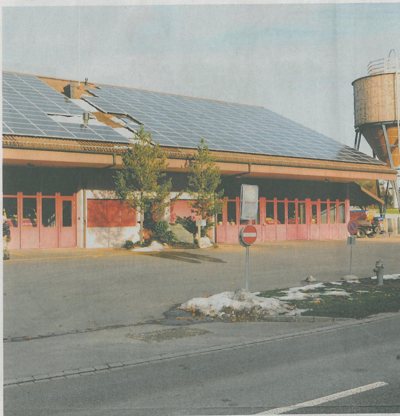
Die Fotovoltaikanlage auf dem Turbenthaler Feuerwehrgebäude wird jährlich rund 70 000 Kilowattstunden Ökostrom liefern. Bild: mad
