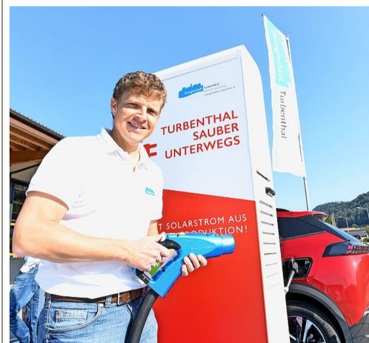
Stephan Meister von der Energiekommission Turbenthal an der neuen E-Tankstelle. Foto: Madeleine Schoder
