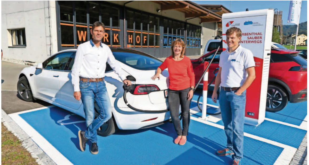
Mit E-Power unterwegs: Gemeindegeschreiber Jürg Schenkel, Gemeinderätin Katharina Fenner und Projektleiter Stephan Meister (von links) zeigen die Ladestation.
