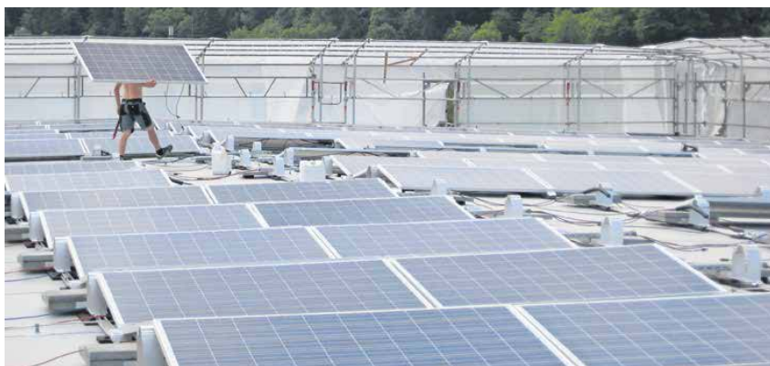
Der Aufbau der Photovoltaikpaneele ist in vollem Gange
