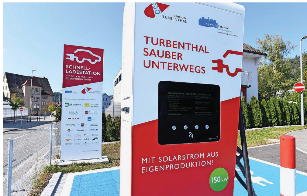
Die Schnellladestation steht beim Werkgebäude Turbenthal an der St. Gallerstrasse. Foto: Madeleine Schoder
