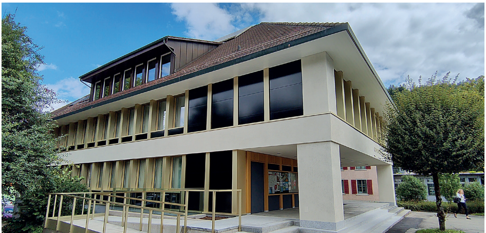
Südseite des Gemeindehauses nach dem Umbau
