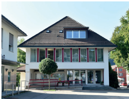
Das Gemeindehaus vor der Sanierung
