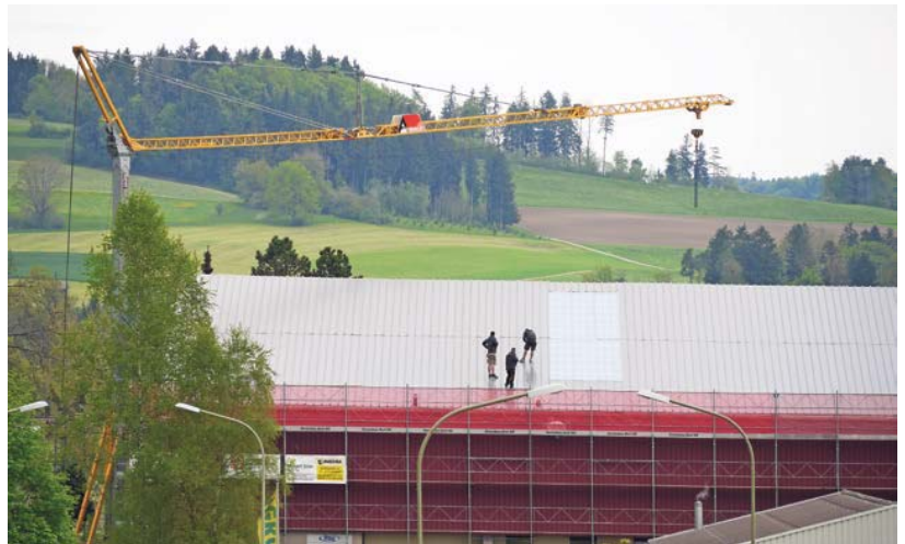
Das Dach der Tennis- und Squashhalle Wila wird für die Solaranlage vorbereitet
